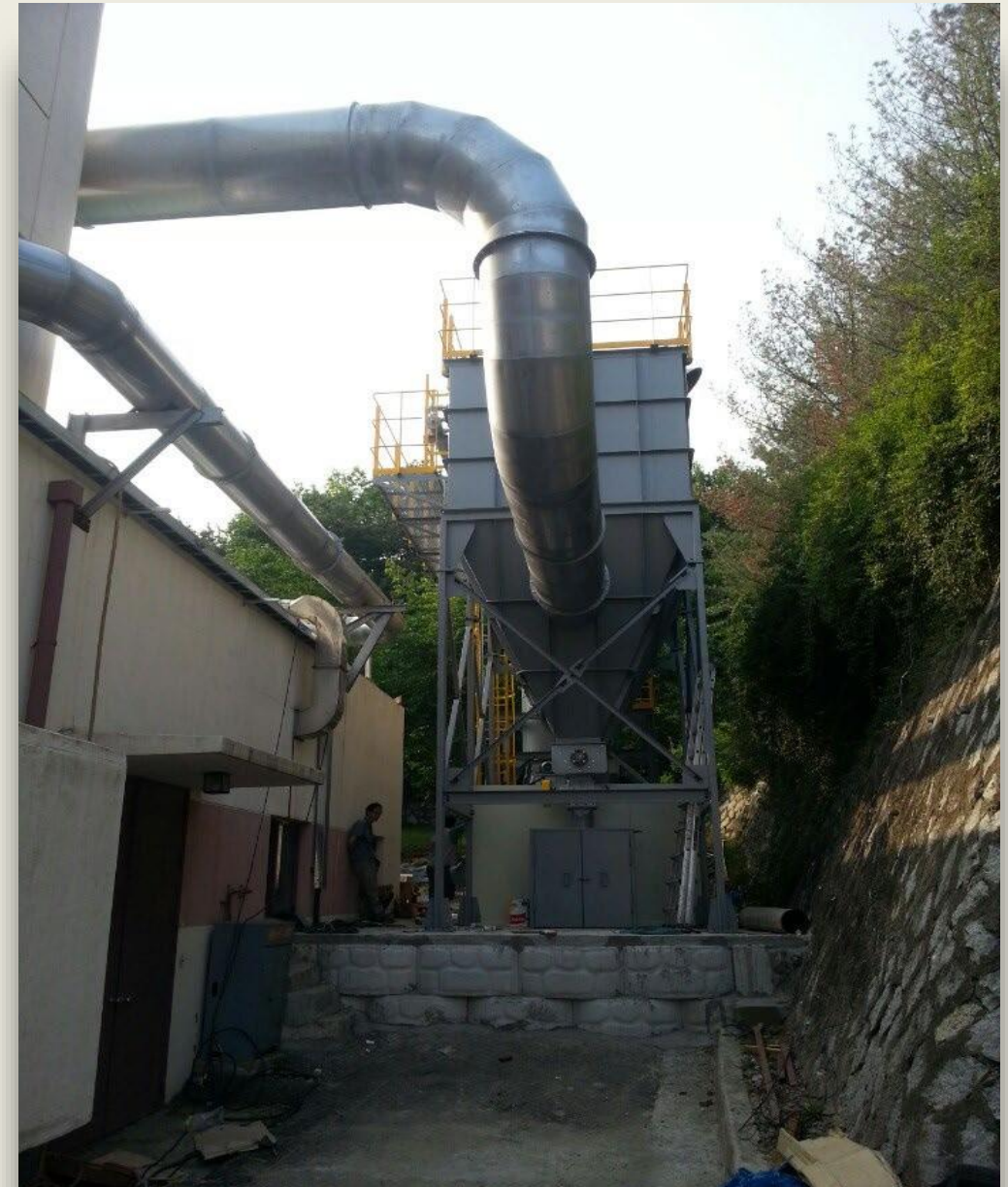
방재시험 연구원 특수시험동 집진설비 제작설치(36,000m 3 /hr )
