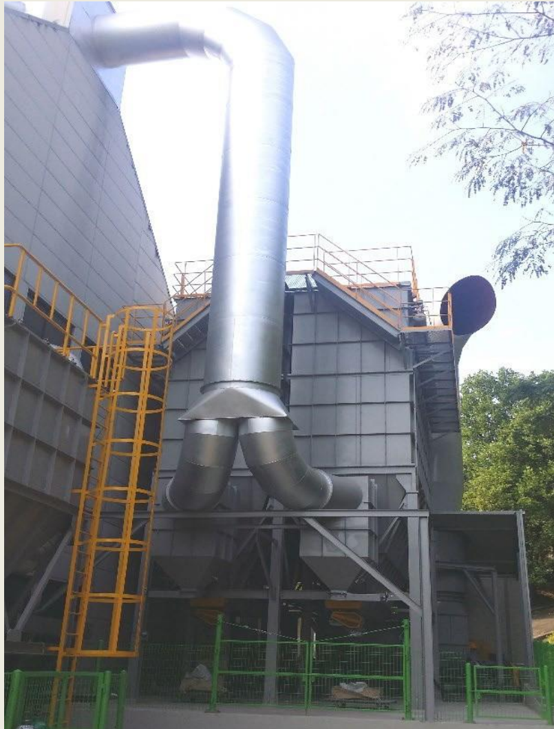
방재시험연구원 종합화재 시험동 집진설비 & DUCT 제작설치 (96,000m 3 /hr)
