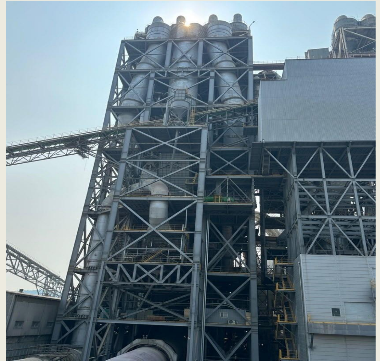
한일현대시멘트(주) 영월공장 #2 염소BY-PASS 제작 설치공사
