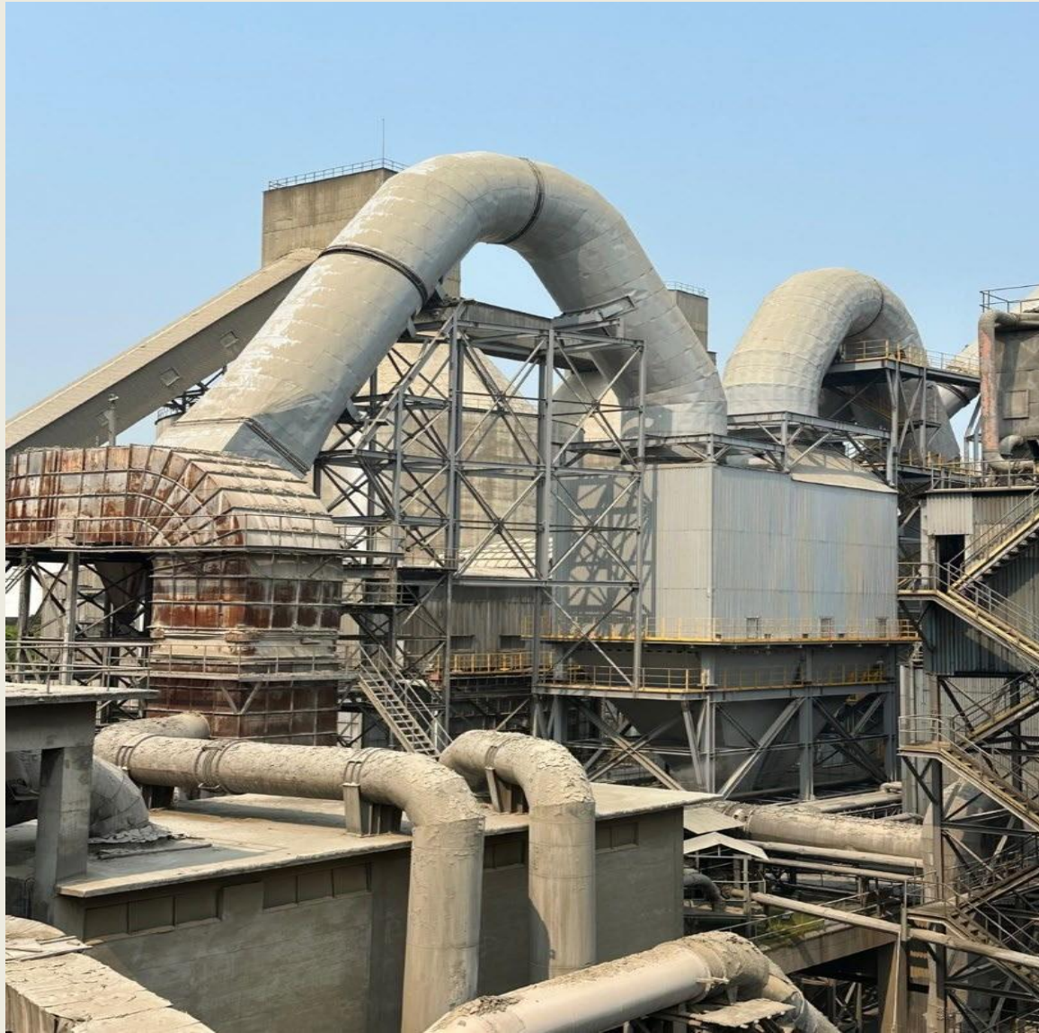
한일현대시멘트(주) 영월공장 #1 AQC 보일러 제작 설치공사
