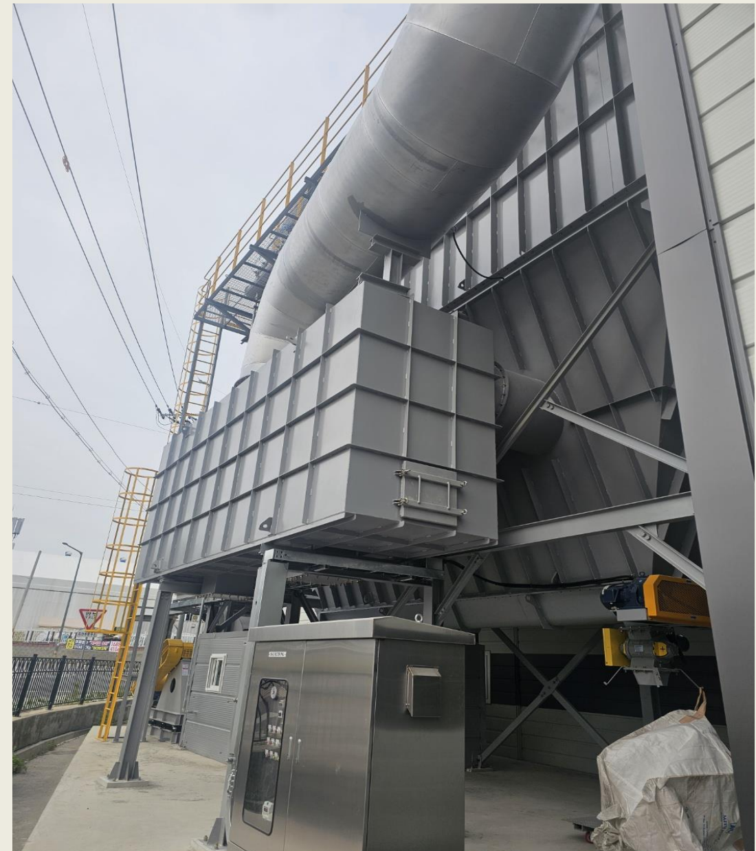
(주)한국 건설 방재 시험 연구원 실물 화재 시험장 집진설비 (96,000m 3 /hr )
