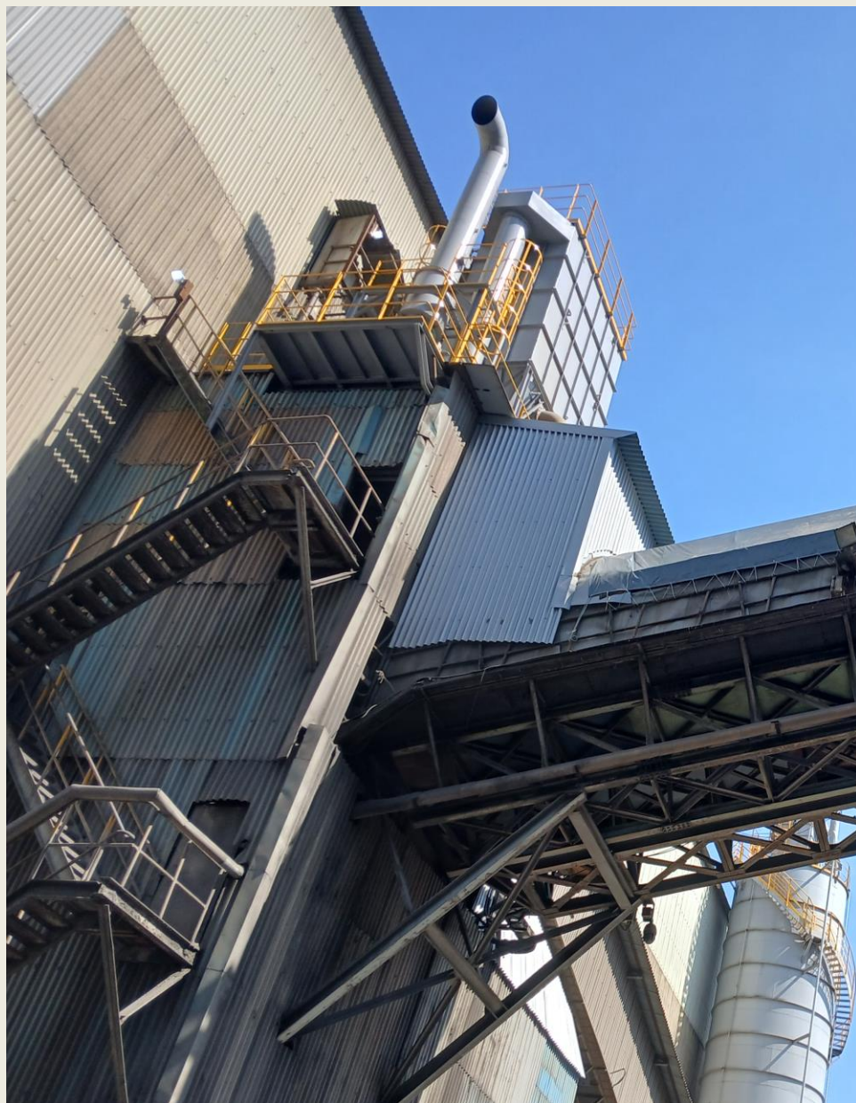
한일시멘트(주) 영월공장 #2K/L R/M FLYASH집진기설치공사 (18,000 m 3 /hr)
